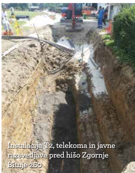
Izvedba slepega hišnega priključka na kanal B4 v Srednjih Bitnjah, podkop pod obstoječimi instalacijami
