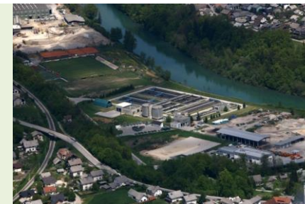
Centralna čistilna naprava Kranj (Foto: Gorazd Kavčič)
