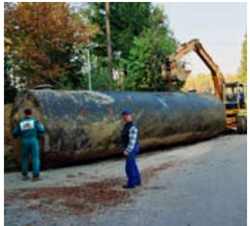
Izkop za požarni bazen v Spodnjih Bitnjah, 2001
